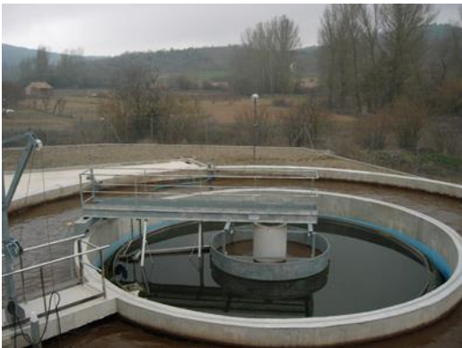
Detall d'una depuradora (arxiu).
