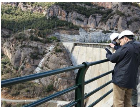
Tècnics inspeccionant la presa de la Llosa del Cavall (arxiu).
