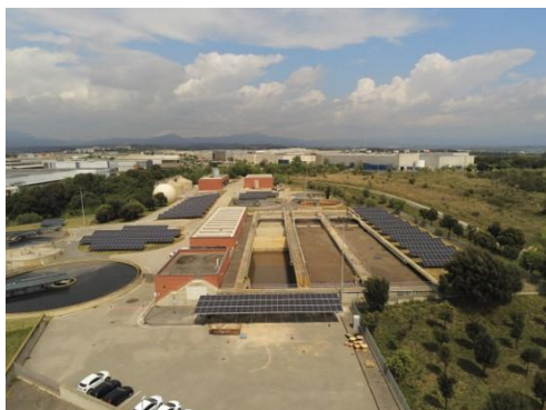
Depuradora de Sabadell riu Ripoll.
