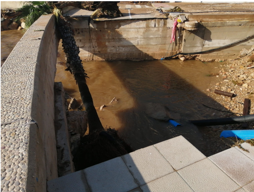
Vista de l'esvoranc, on es distingeix el calaix del desguàs del barranc de Sant Jaume
