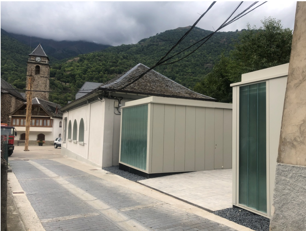
Rehabilitació de la Casa deth Haro i nous edificis d'accés i serveis.
