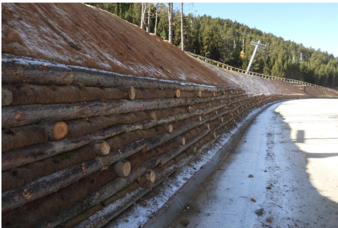
Detall del mur de contenció realitzat utilitzant tècniques de bioenginyeria.
