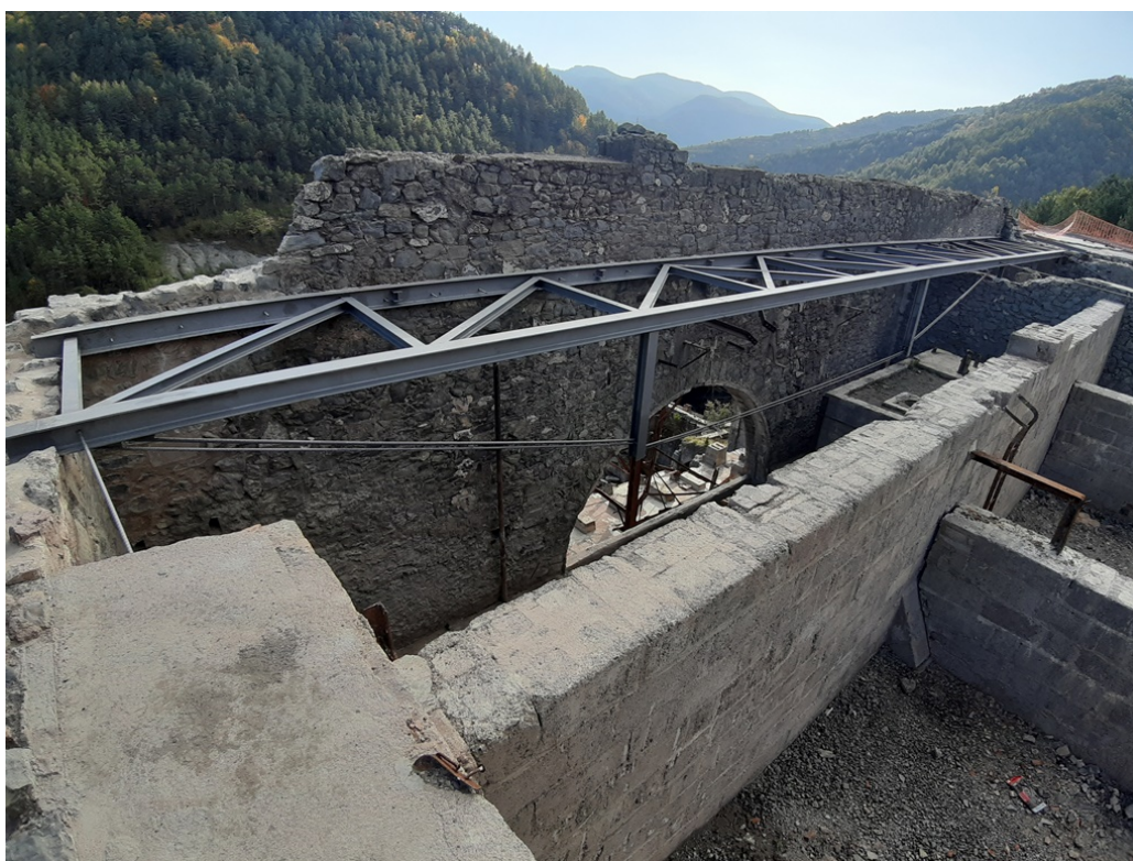
Estructures de reforç construïdes
