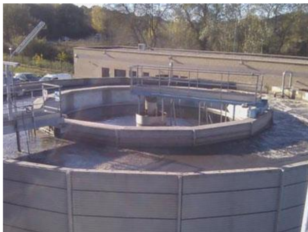
1. Detall de la depuradora de Quart.
