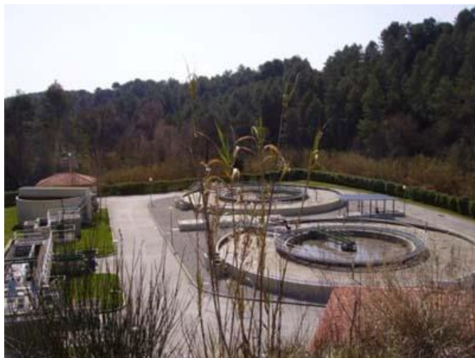
1. Depuradora de Masquefa.
