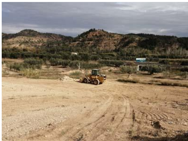
1. Moviments de terres per adequar el terreny.
