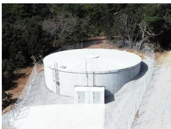
1. Dipòsit d'aigua de Prades.
