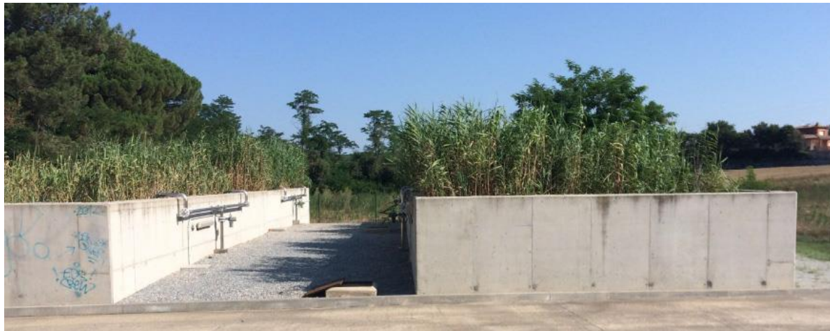
1. Exemple del tractament natural (rizocompostatge) que s'emprarà per al tractament dels fangs.
