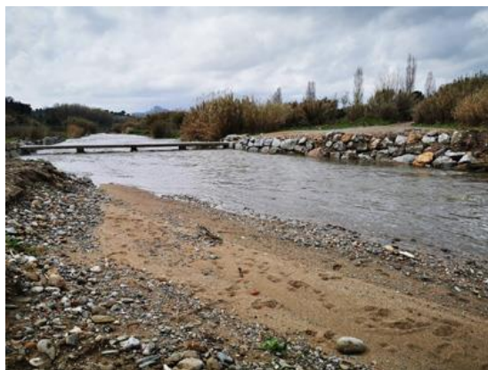
2. Tram del riu Besòs a l'altura de la Llagosta, durant la inspecció efectuada avui.
