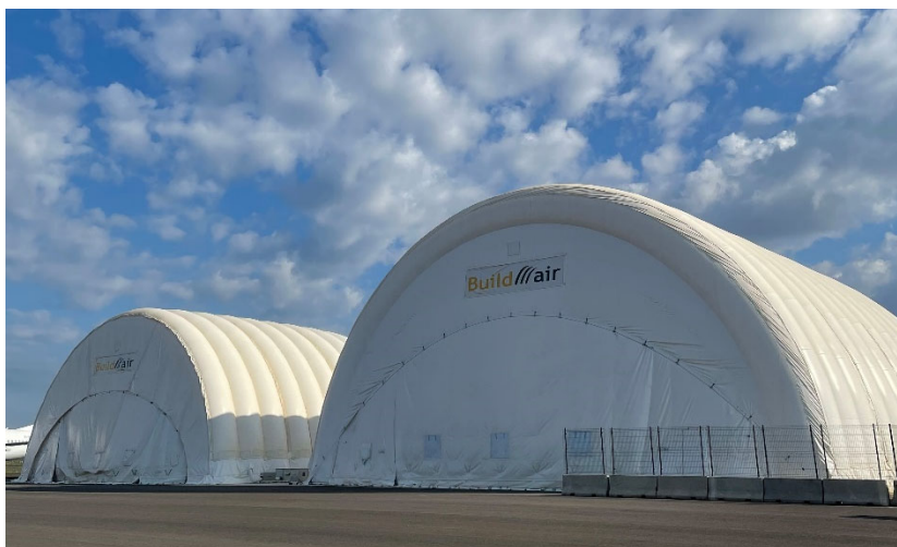
Imatge de dos hangars a l'aeroport de Lleida-Alguaire
