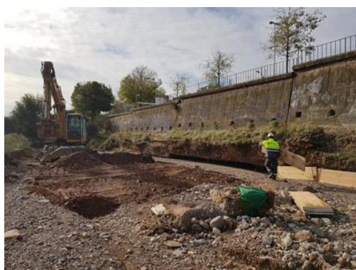
1. Adequació dels murs d'una riera per a minimitzar l'impacte de les inundacions (arxiu).
