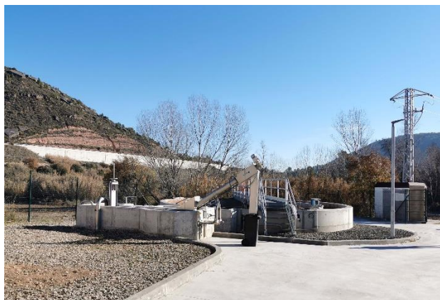
2. Detall de la depuradora de Rajadell.
