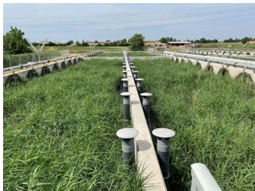
2. Llits de rizoma de la depuradora de Torrefarrera i Torre-serona.
