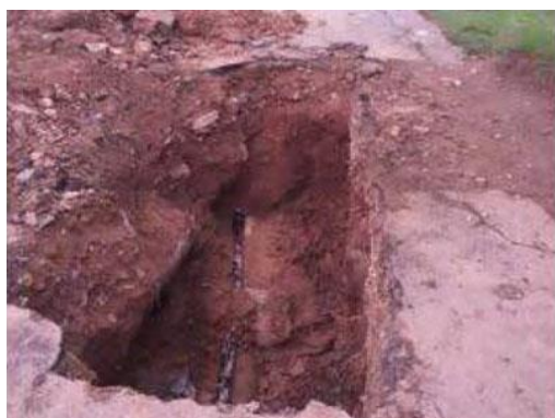
1. Detall de la reparació d'una conducció d'aigua, dins del marc d'aquests ajuts.
