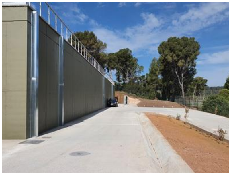
1. Vista de l'exterior del dipòsit de Can Salvi, a Sant Andreu de la Barca.
