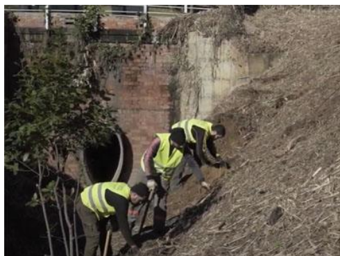
1. Treballadors fent tasques de manteniment i conservació de lleres en zona urbana.
