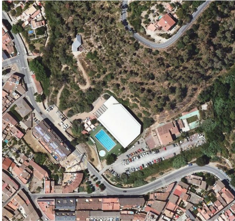
Vista aèria actual del pavelló.
