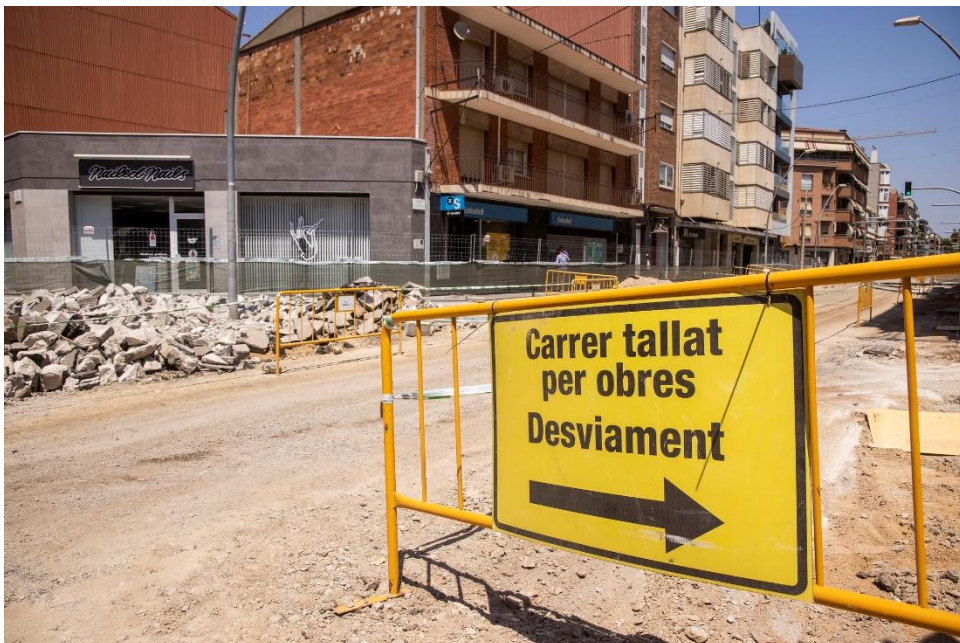
Obres a la C-245.
