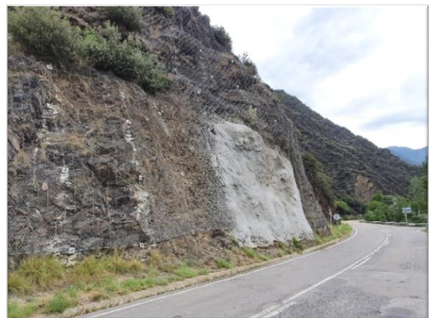
Intervencions en talussos en vials que oculten els afloraments naturals, com ara els gunitats.
