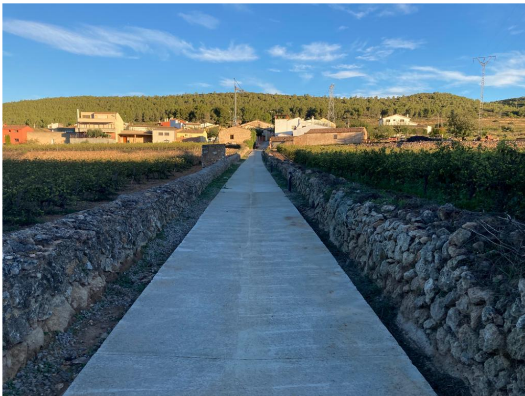
Pavimentació d'un tram del camí entre l'Arboçar de dalt i l'Arboçar de les roques
