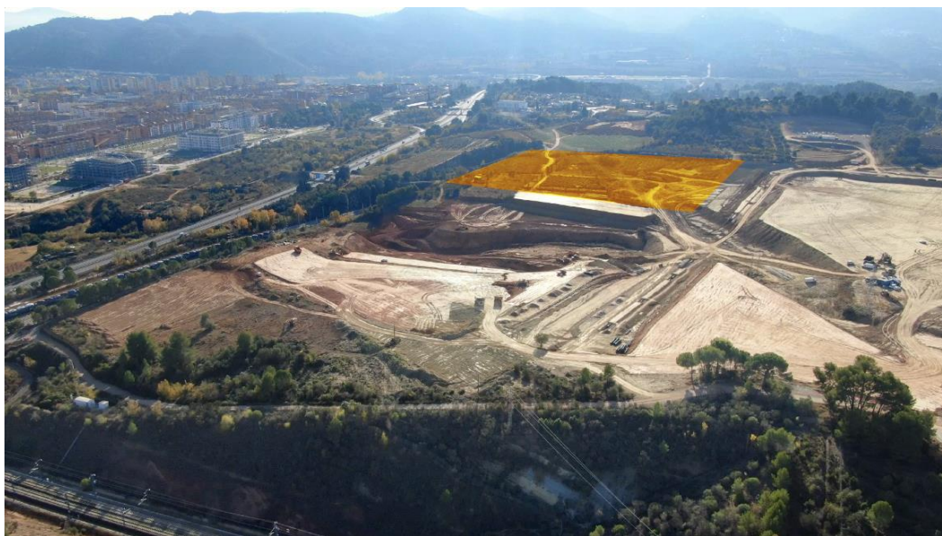
Vista aèria de Xàmenes amb la parcel·la 3 assenyada
