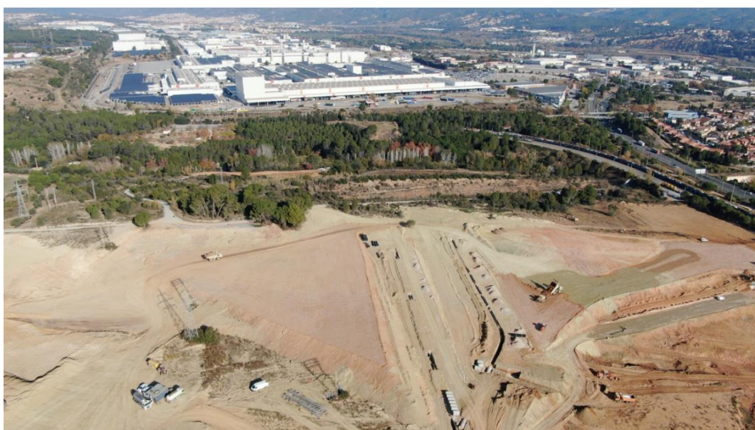
Vista aèria de Xàmenes on es veuen els moviments de terra i l'entorn
