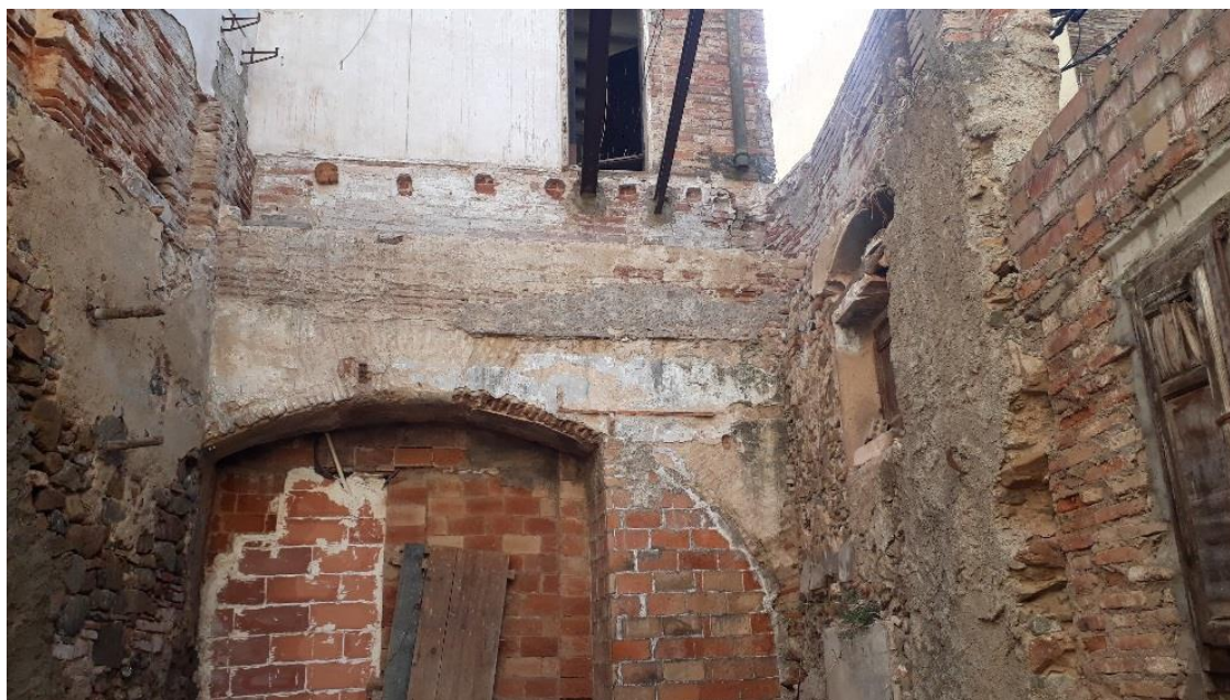
Estat actual de l'espai
