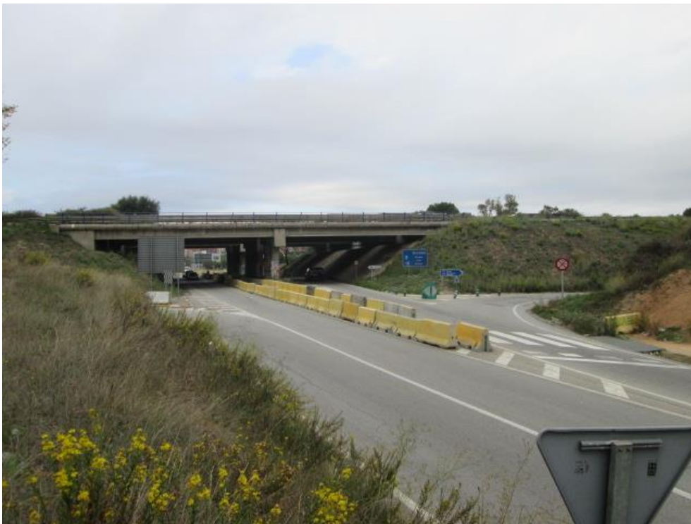
Estat actual de la connexió sota la B30-AP7 al sector Can Sant Joan
