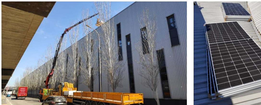
Tasques prèvies a la instal·lació de plaques
