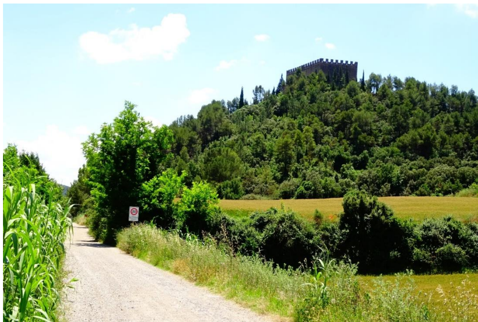
Imatge 3. Traçat proper a elements patrimonials d'interès. Fotografia de Josep Calduch
