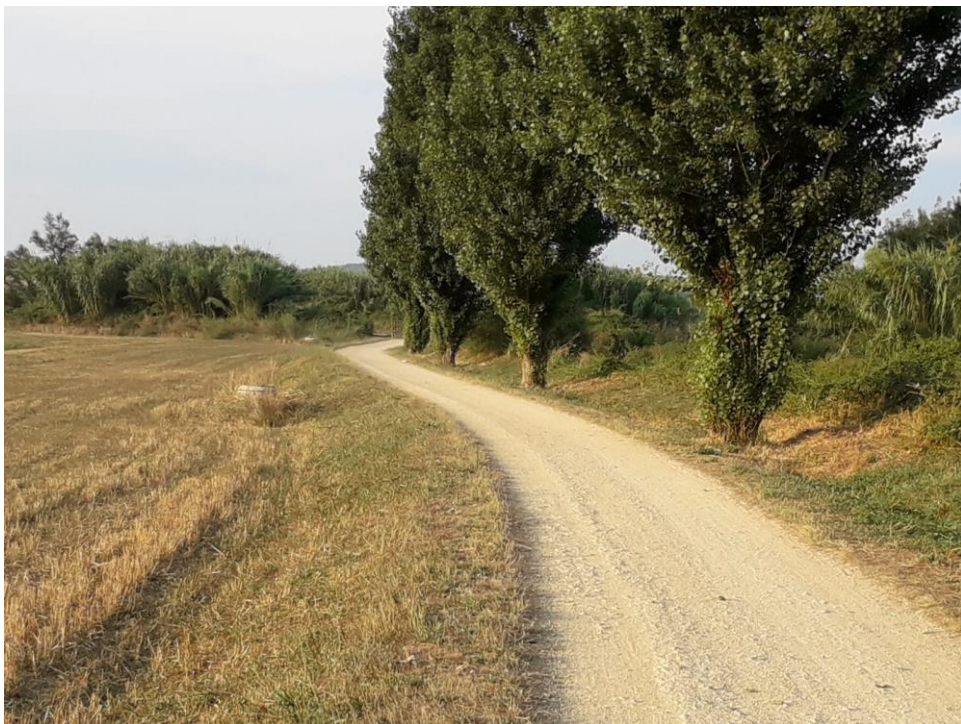
Imatge 6. Camí amb paviment permeable. Fotografia de Josep Caldcuch
