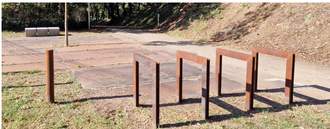
Imatge 13. Ús d'acer patinable al P.N de la Zona Volcànica de la Garrotxa. Fotografia de Xavier Puig
