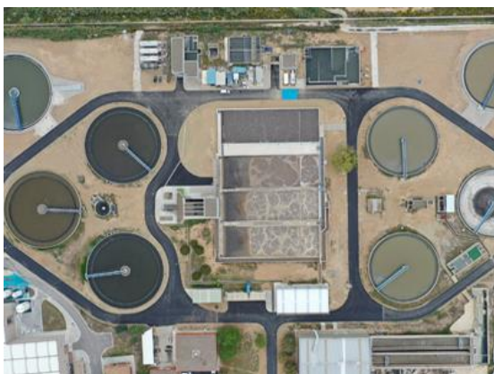
1. Vista aèria de la depuradora de Vila-seca i Salou
