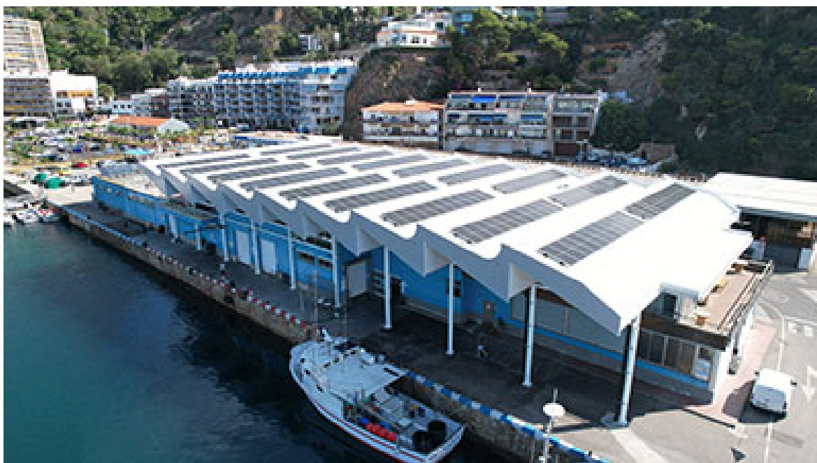
Nova coberta amb 200 plaques solars.
