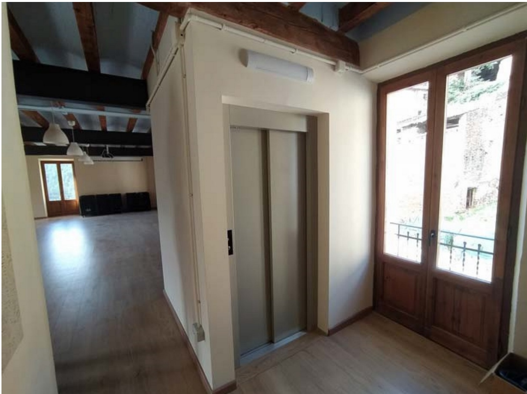
Instal·lació del nou ascensor
