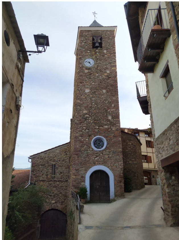
Exterior de l'església de Sant Serni a les Valls d'Aguilar (Alt Urgell).
