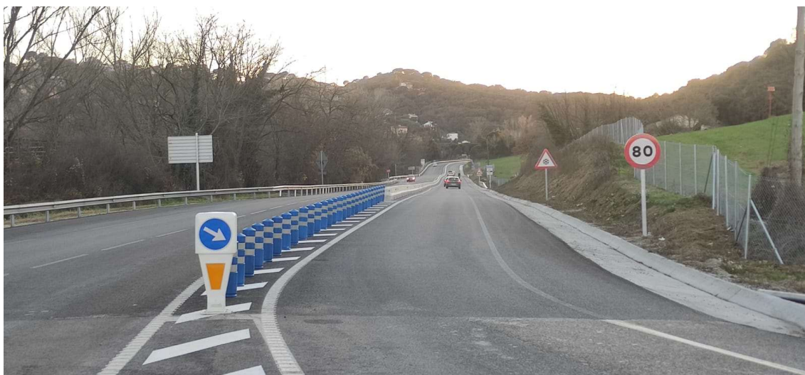
L'obra donarà continuïtat al tram 2+1 entre Sant Celoni i Vilalba Sasserra
