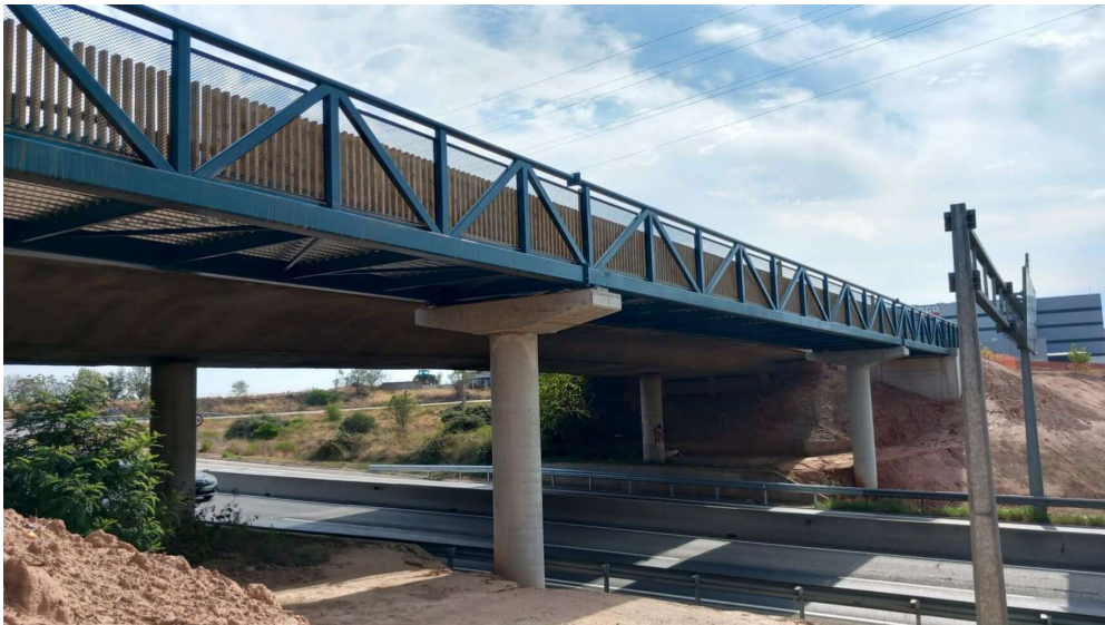
Vista general de la nova passarel·la sobre la carretera C-55 (Manresa)
