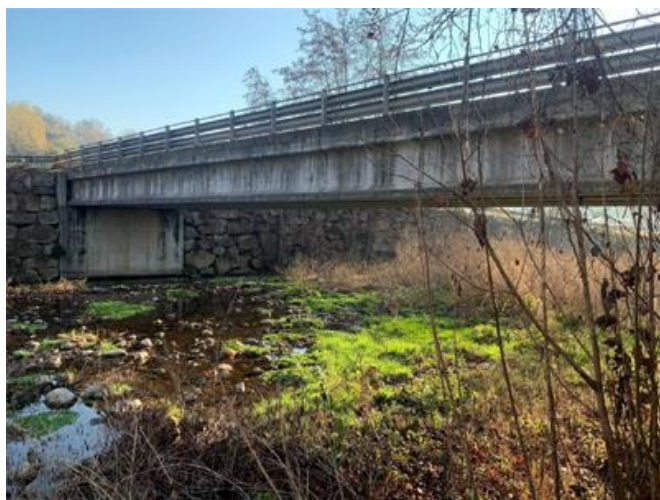
1. Pont de Santa Brígida, a Amer, per damunt del riu Brugent, on s'habilitarà la nova estació d'aforament.
