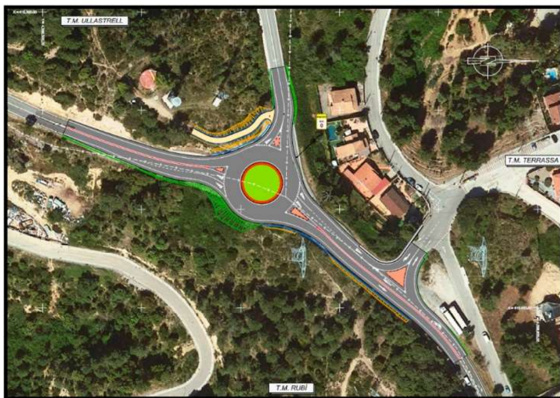
Una de les rotondes que es construirà, a la C-243c a Ullastrell
