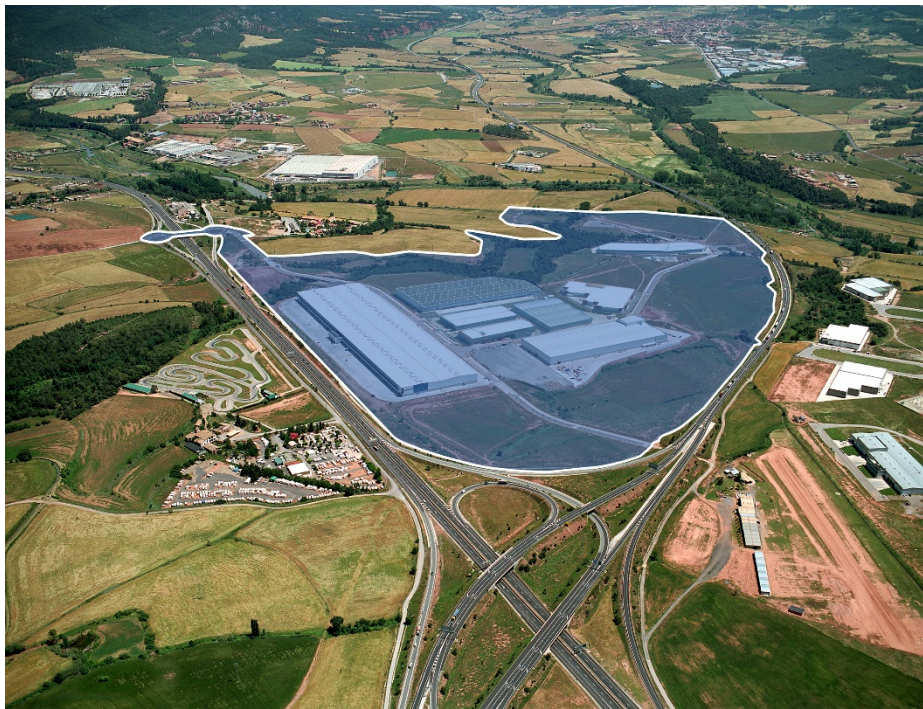
Vista general del sector Plans de la Sala.
