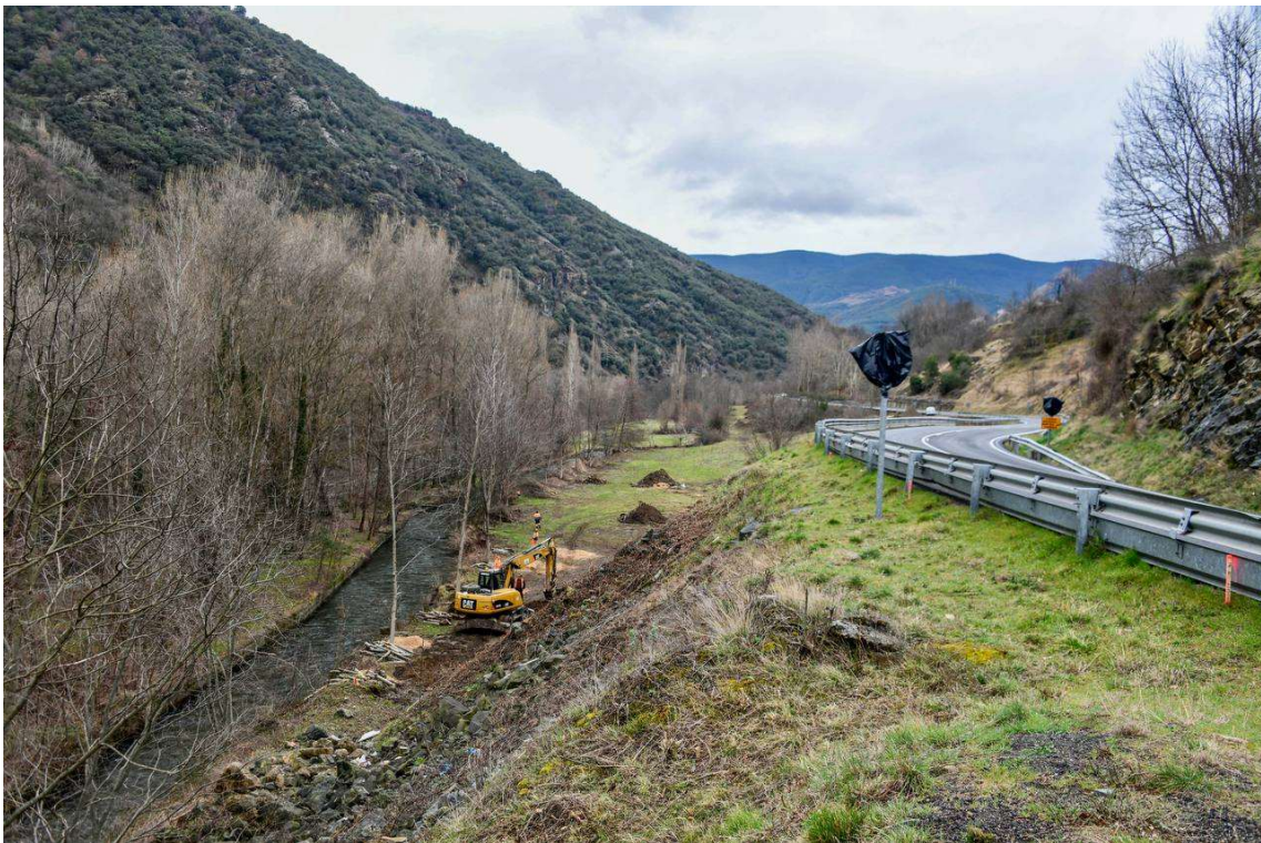
Primeres tasques de l'obra
