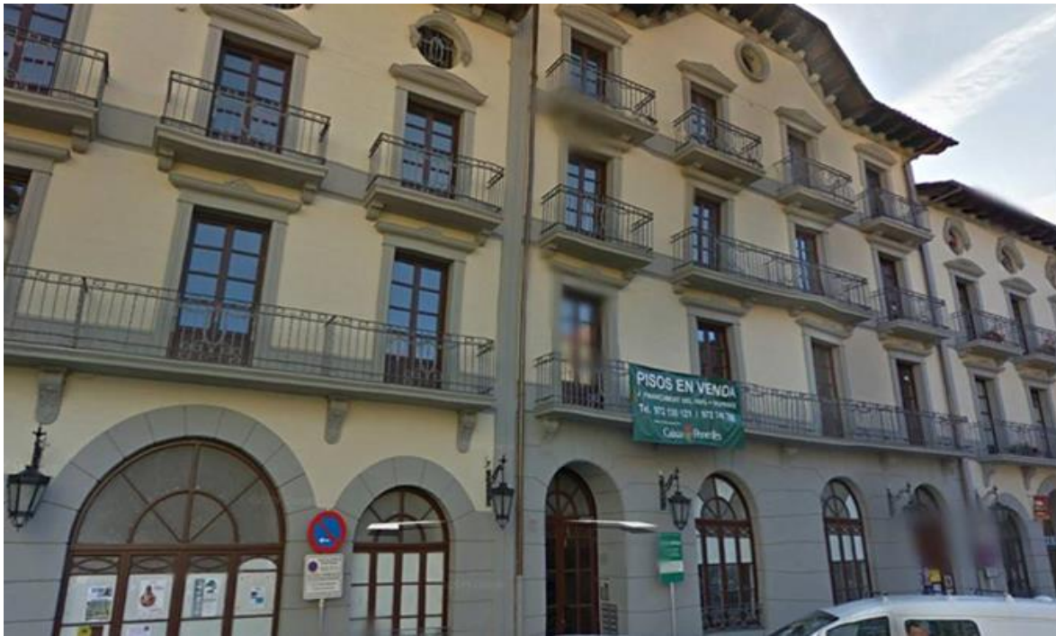
L'edifici de Camprodon.
