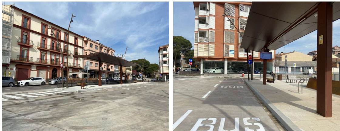
Dues imatges de la nova estació
