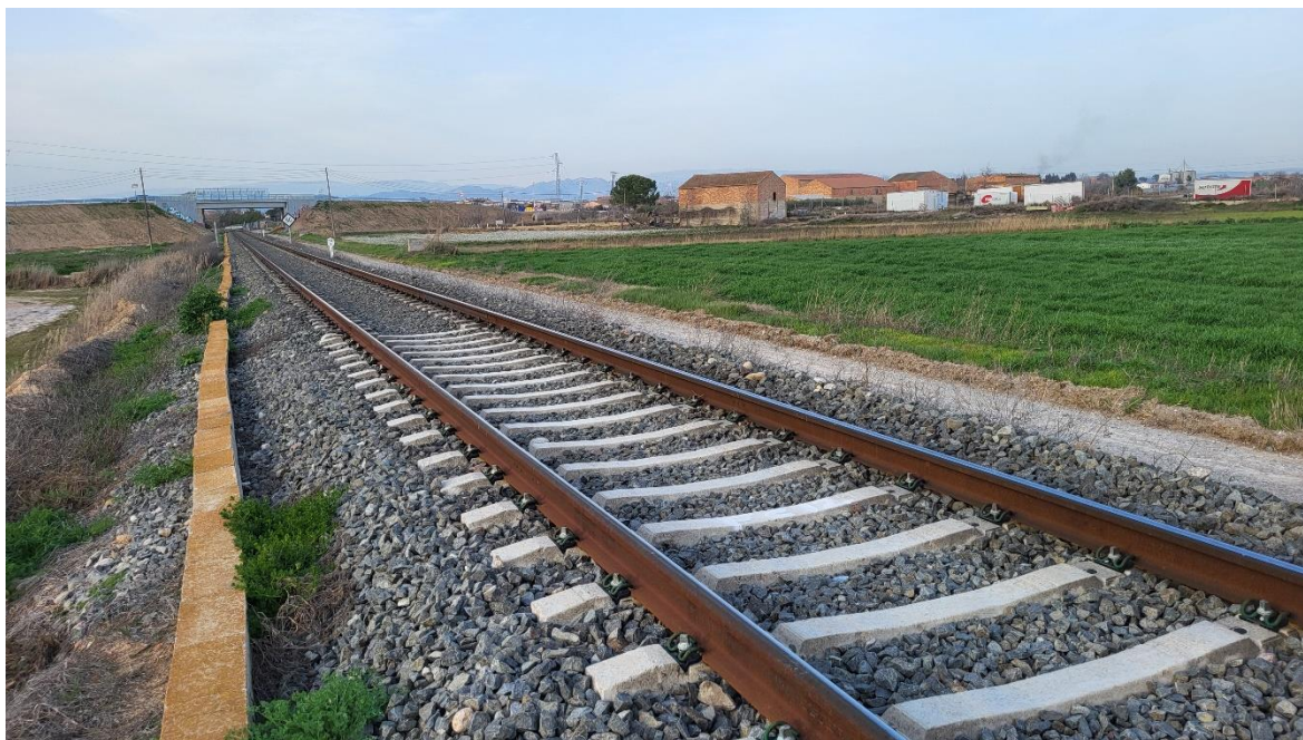
Punt de la via a partir del qual es farà la renovació de travesses i carrils.
