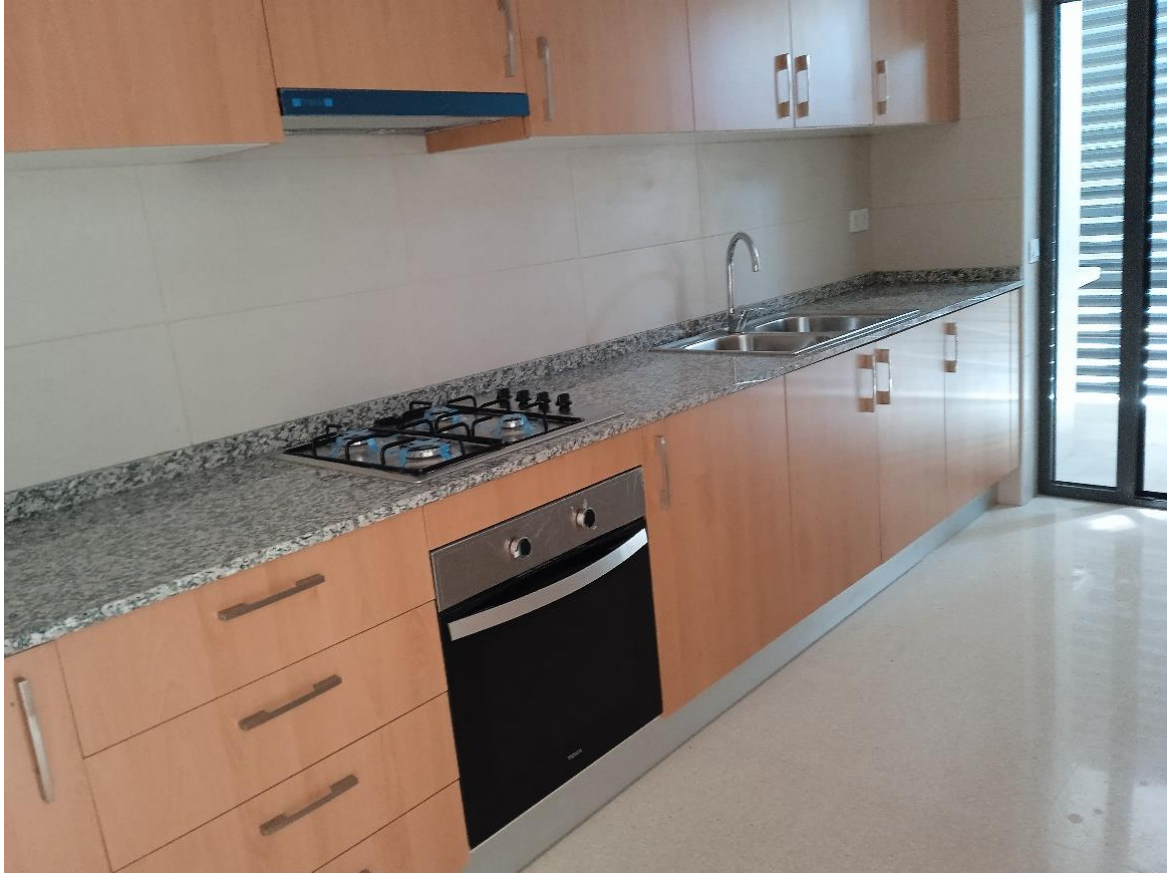
Vista de la cuina dels habitatges de la nova promoció a Sant Roc.
