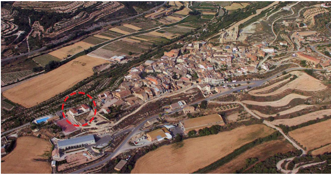
Ubicació de l'antiga caserna, en un extrem del nucli urbà de Ciudadilla.
