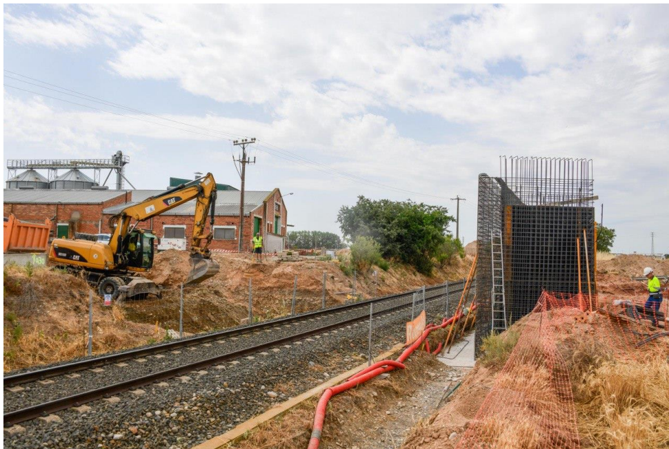
Treballs de FGC a Vallfogona de Balaguer.
