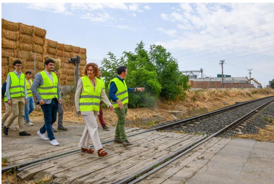
La consellera, a les obres per a la supressió del pas a nivell a Vallfogona de Balaguer.
