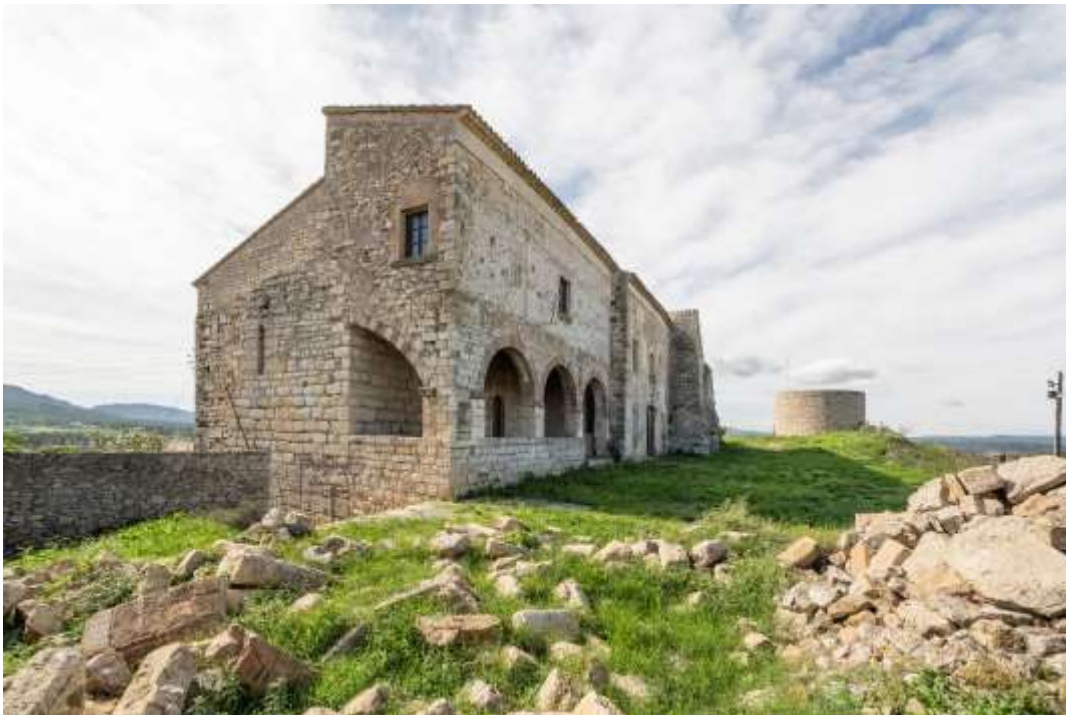
L'edifici principal del Castell de Barberà de la Conca
