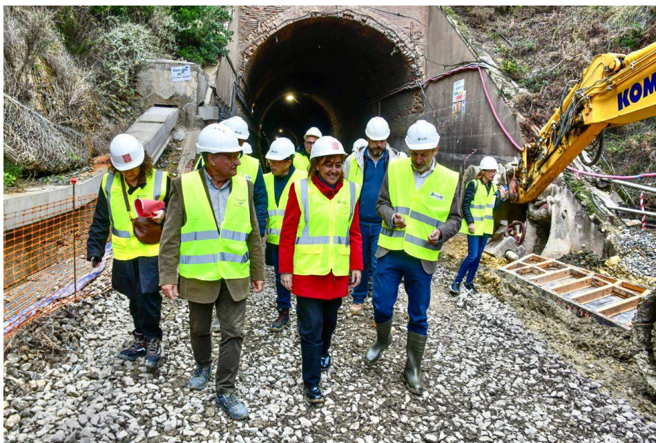
La consellera Paneque, durant la visita a les obres del túnel de Roda de Berà
