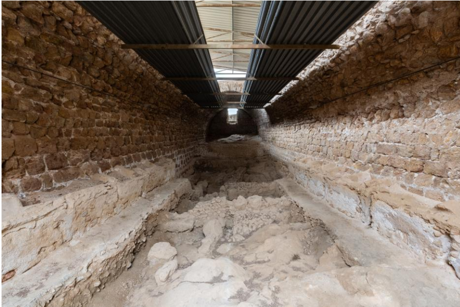
Imatge de l'interior de les cavallerisses
