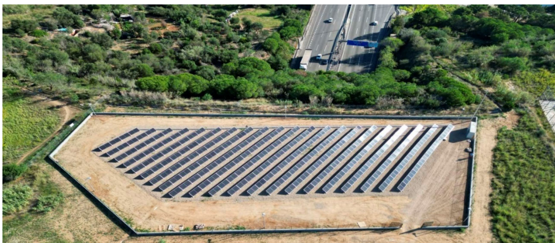
Instal·lació fotovoltaica sobre el túnel de la C-32, a Mataró
