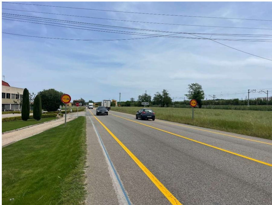
Tram on es construirà la rotonda
